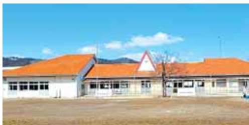
改修される第一幼稚園
