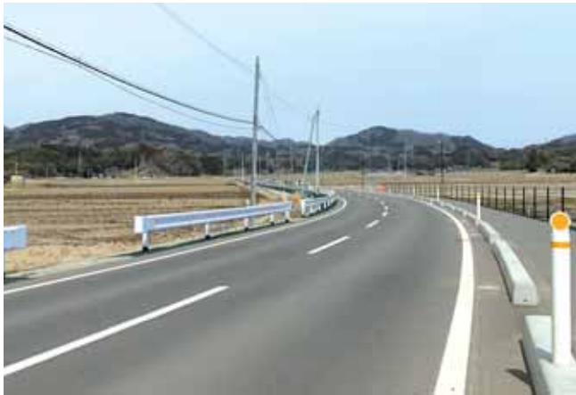
完成した町道富沢16号線
