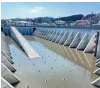
完成した鷺沼5号調整池
