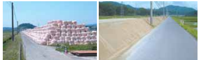
工事開始後の盛土
