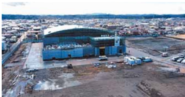
完成にむけて順調に工事が進む
