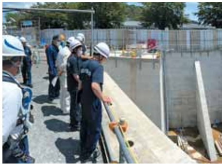
鷺沼5号調整池の現地調査
