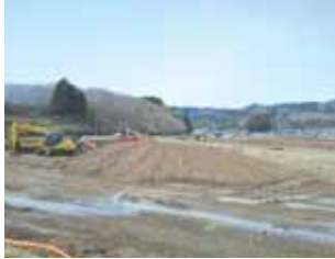
葉坂地区のほ場整備 工事現場
