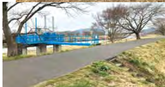
設置済の白石川堤深川排水樋管(上) 東船迫地区雨水対策排水管設置予定地(下)
