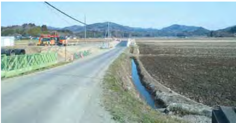
左岸低地排水路の橋も完成
