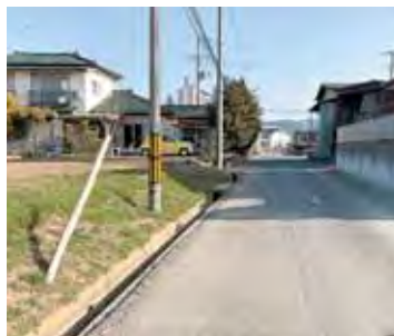
今後の工事に期待（白幡地区）
