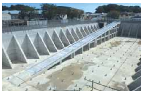
鷺沼5号調整池
