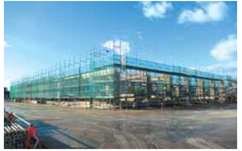
建設中の総合体育館
