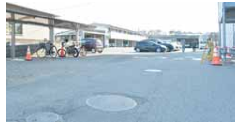
役場庁舎駐車場
