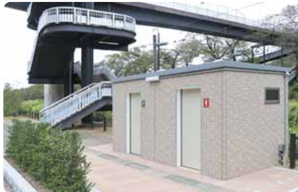
桜の小径に新設したトイレ
