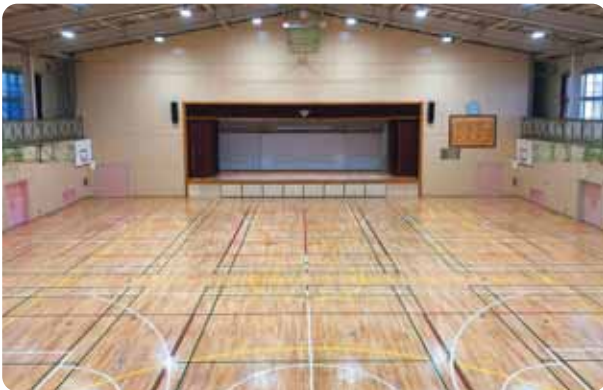
大規模改造工事を行った船迫中学校体育館
