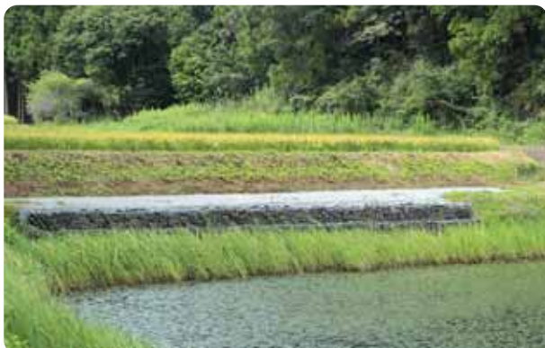
復旧工事を行った野竹内ため池(成田地区)
