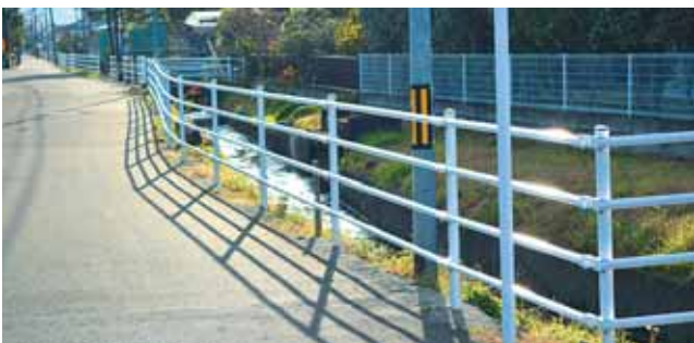
用水路への転落を防ぐための柵設置（西住地区）に活用
