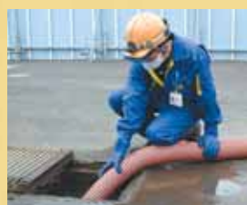
汚泥の抜き取りを行う穴戸さん。
