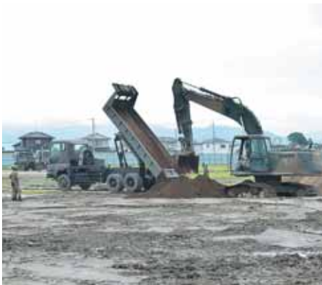
自衛隊の訓練の一つとして、さまざまな重機を使い敷地造成していきます。
