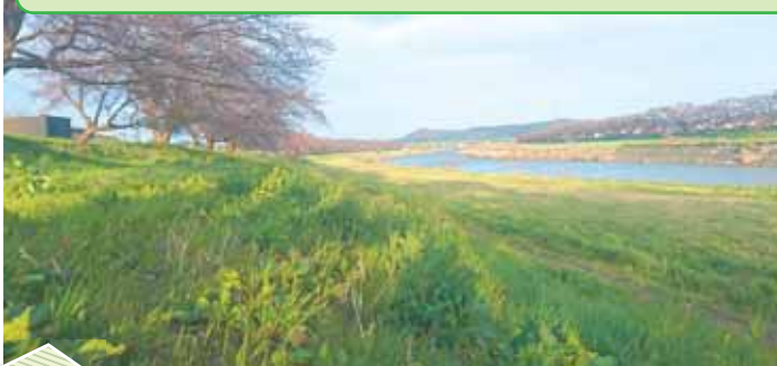
白石川左岸堤防
