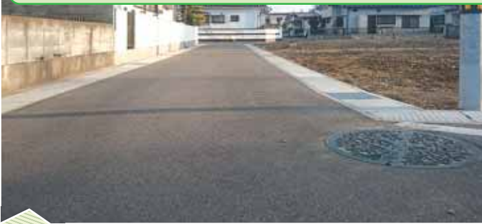
北船岡地区雨水対策工事箇所付近
