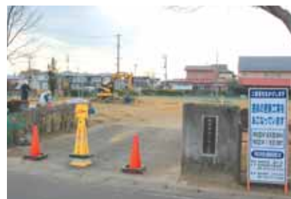
新しい遊具の設置工事は、1月末に完成予定です。
