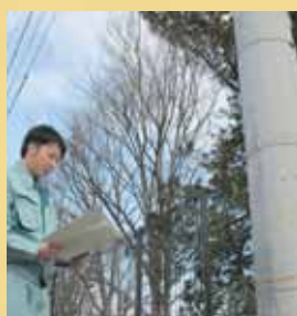
図面を基に、施工した電柱の確認を行う後藤さん。
