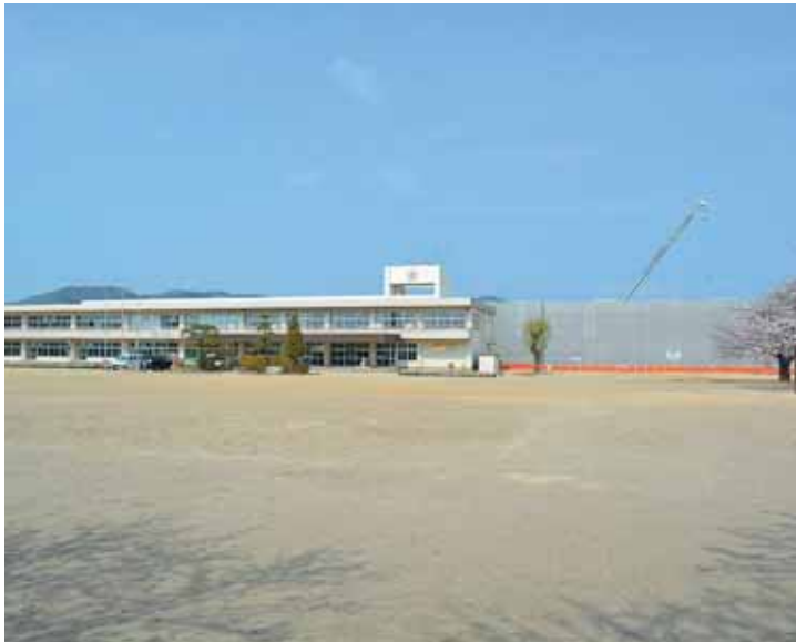
大規模改造工事中の船岡小学校
