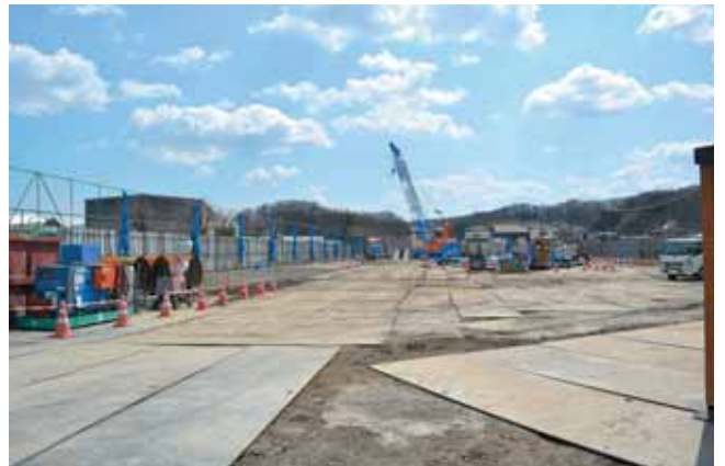
整備が進む鷺沼調整池
