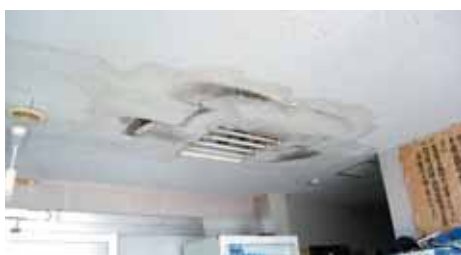
改修される槻木体育館
