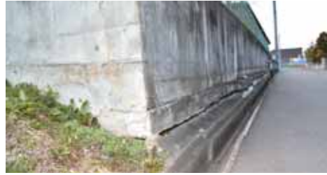
今回の工事箇所
