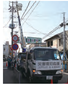
ライフラインの復旧作業
