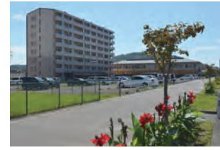
北船岡町営住宅2号棟
