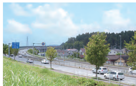
JR東北本線と立体交差する槻木高架橋
