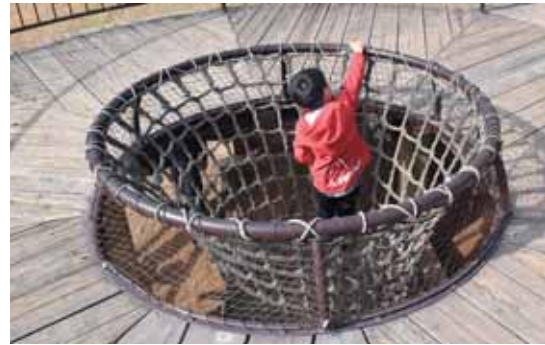
転落防止ネットを設置した遊具
