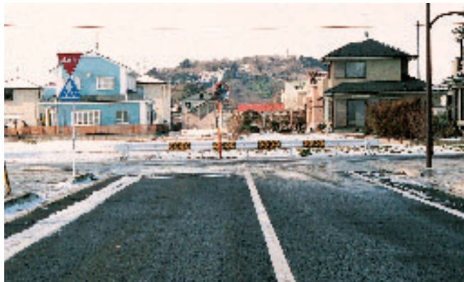
工事中の新栄通線
