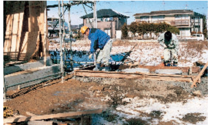
工事中の合併処理浄化槽
