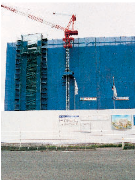
建設中の二本杉住宅
