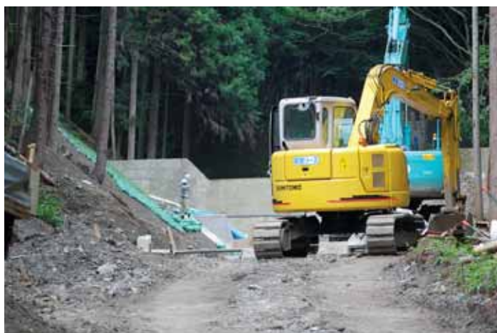
進む急傾斜地での治山ダム設置工事
