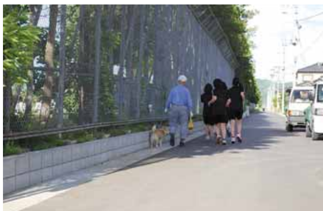
改修された船岡中学校フェンス
