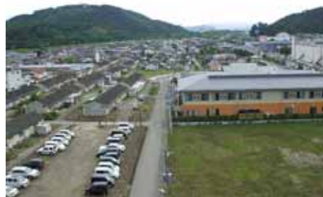
高層(8階建)の町営住宅がもう1棟建ちます
