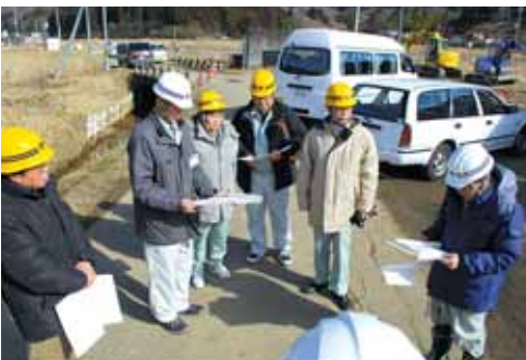
町道富沢11号線改修工事の視察
