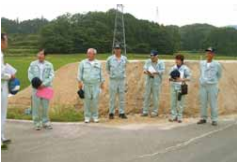
町道富沢16号線道路改良工事の現場
