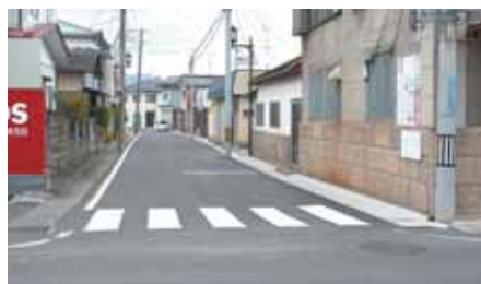
今回の雨水対策工事箇所
