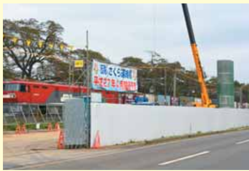
工事が進む(仮称)さくら連絡橋
