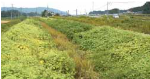
かさ上げ工事が決まった槻木五間堀川
