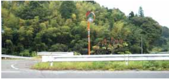
成田地区に新設されたカーブミラー
