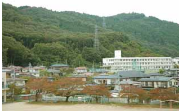
災害時の避難経路の見直しが必要な西船迫地区
