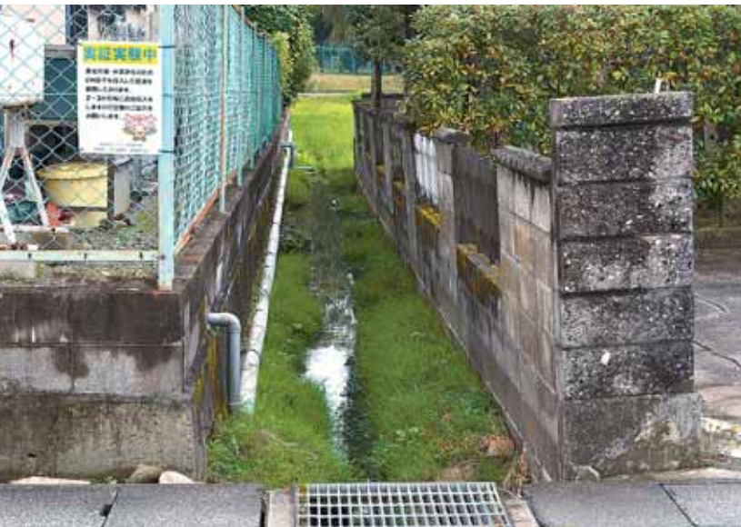
実証実験中の土水路
