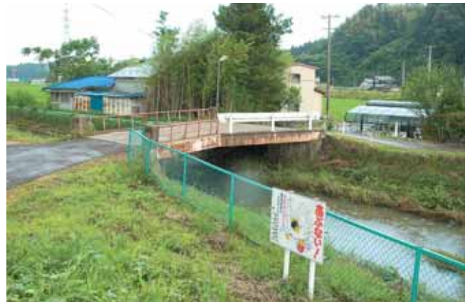
浸水対策が求められる境橋付近
