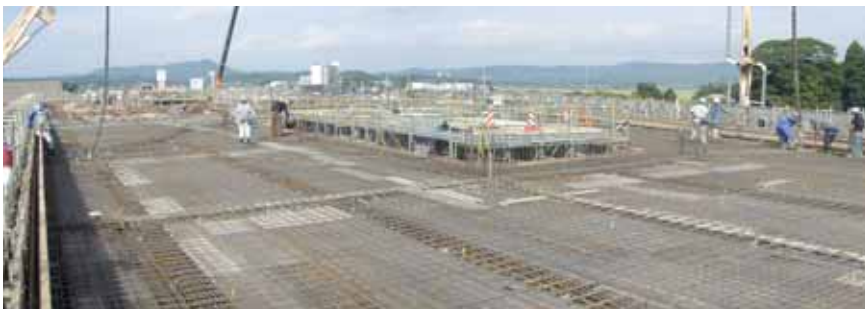
▲建設が進む槻木中学校の新校舎
