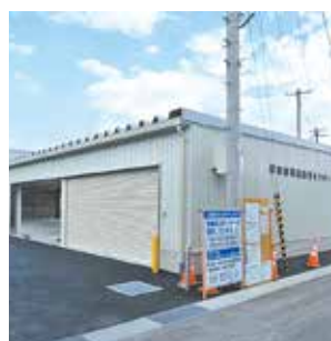
完成間近な 柴田町地域防災センター
