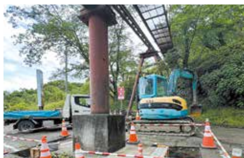
スロープカー軌道下部工事
