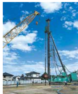
工事が進む新図書館
