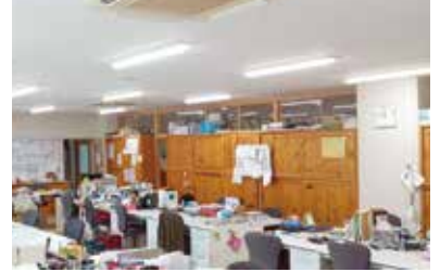
昨年度LED化工事が完了した槻木中学校
