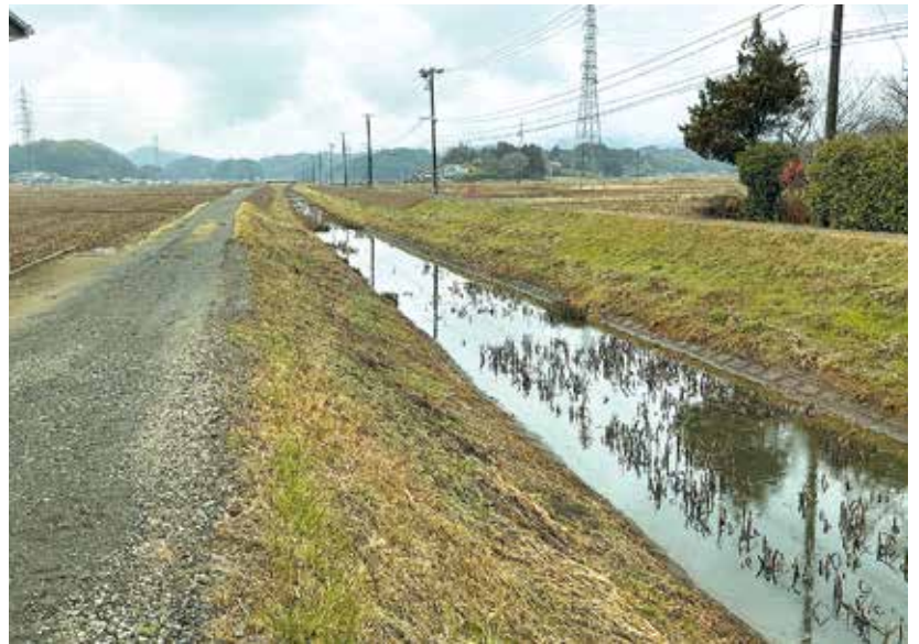
着実に進む槻木五間堀改修工事の現場
