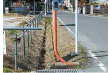
槻木上町地区の水路改修工事
