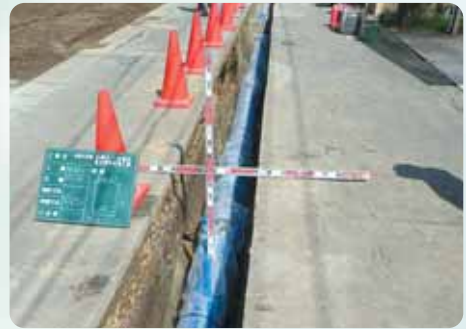
配水管の布設工事
