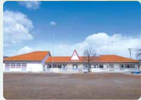
児童館への改修を進める旧第一幼稚園
