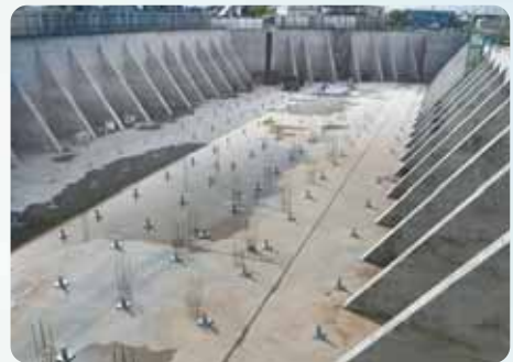
完成した鷺沼5号調整池
