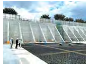
令和5年度中に完成を目指す鷺沼5号調整池
