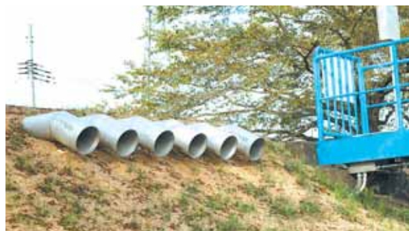
東船迫地区雨水対策排水管設置工事
