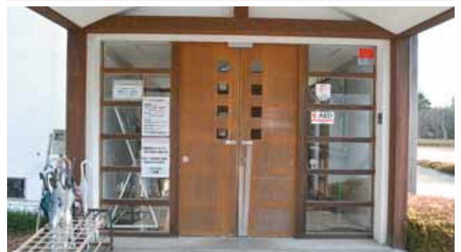
図書館入口を修繕
