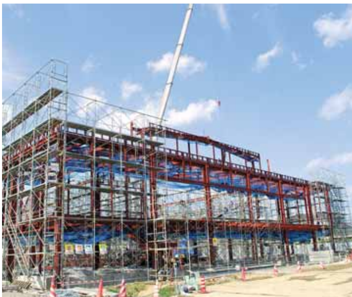
着々と進む船中体育館建設工事
