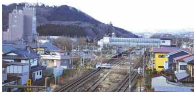
白石川堤防と船岡城址公園を結ぶ船岡駅跨線橋
