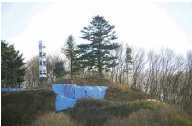
建設中の展望デッキ
