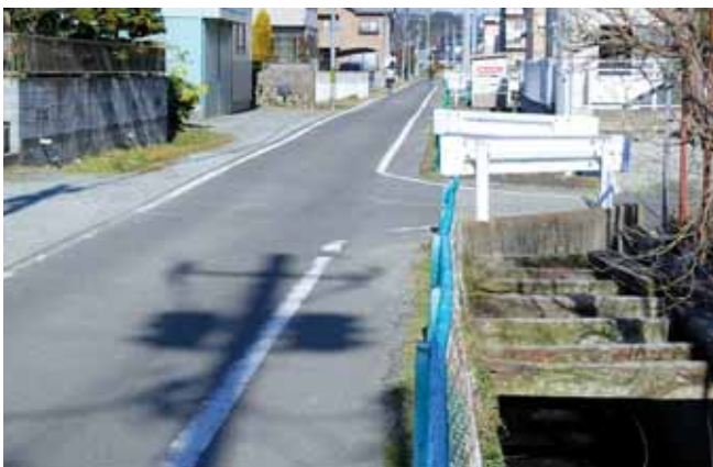
整備の要望が多い町道船岡東 43 号線
