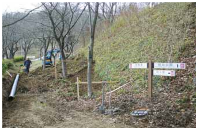
工事が進む船岡城址公園の園路
