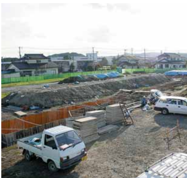
工事中の船岡保育所(新築)
