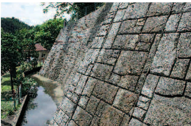
災害に備えて(船岡南地区)
