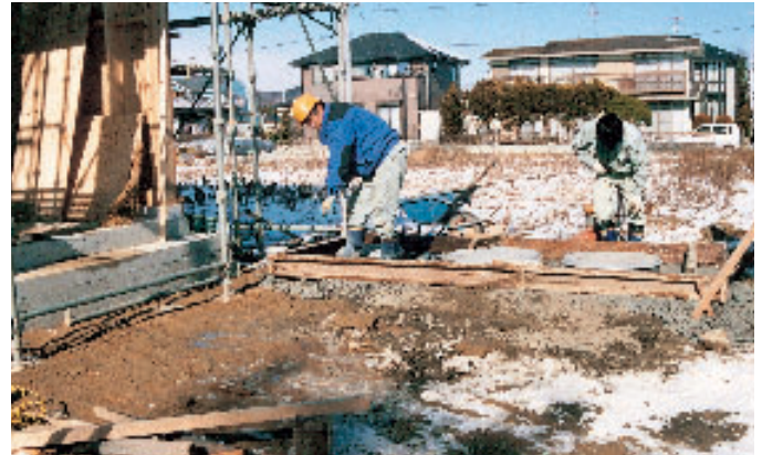
工事中の合併処理浄化槽
