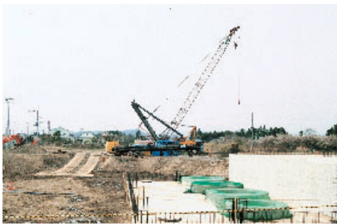
四日市場排水機場
