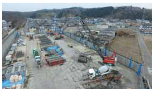
平成31年度完成予定の鷺沼排水区5号調整池
