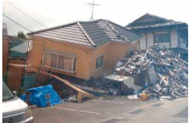
新耐震基準でも倒壊した家屋(熊本地震)
