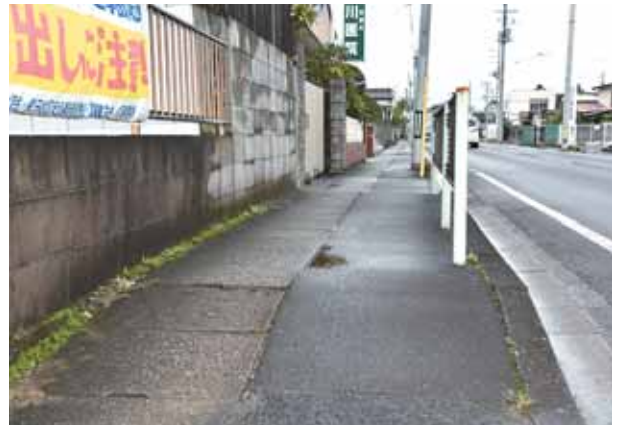
高低差がある歩道
