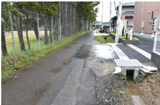
整備が望まれる船岡中学校西側土側溝
