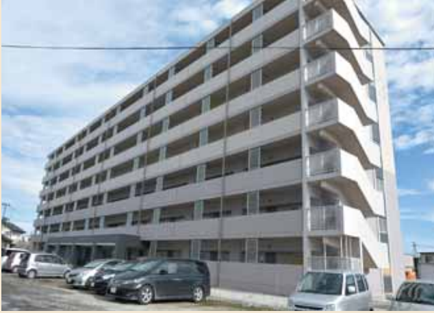
北船岡町営住宅3号棟建設事業
