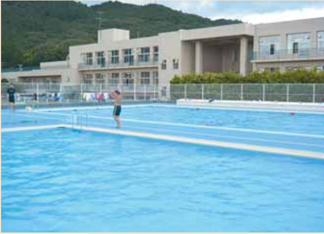
船迫小学校プール改築工事
