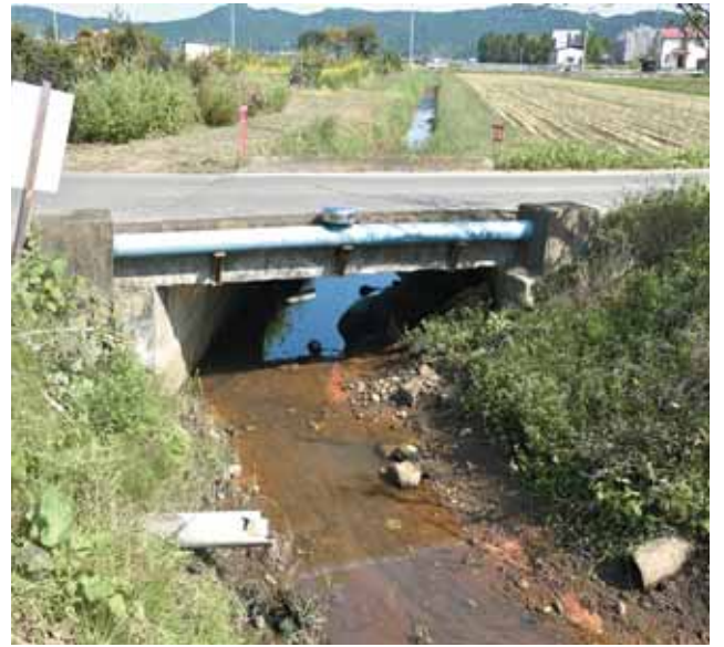
改修予定の上名生21号線橋梁
