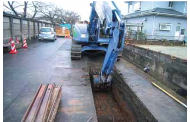
下水道工事作業現場(清住町地区)
