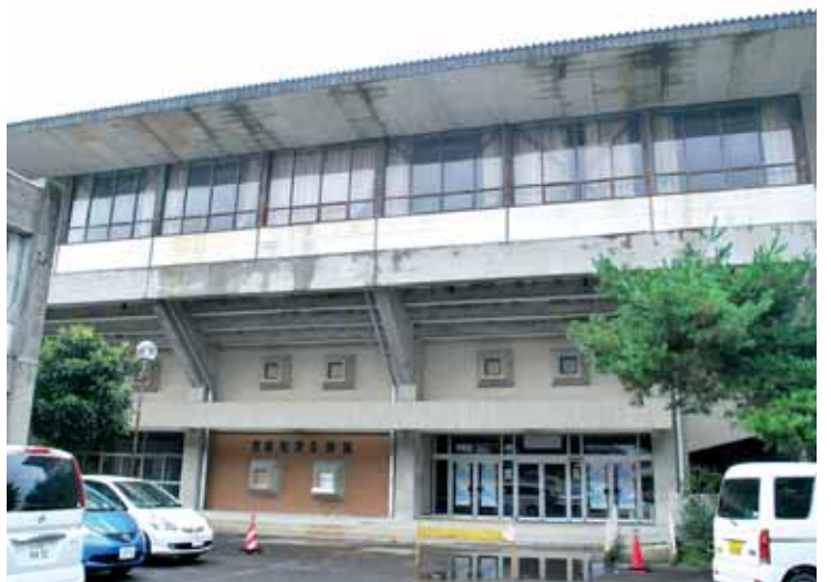
立入禁止となっている町民体育館
