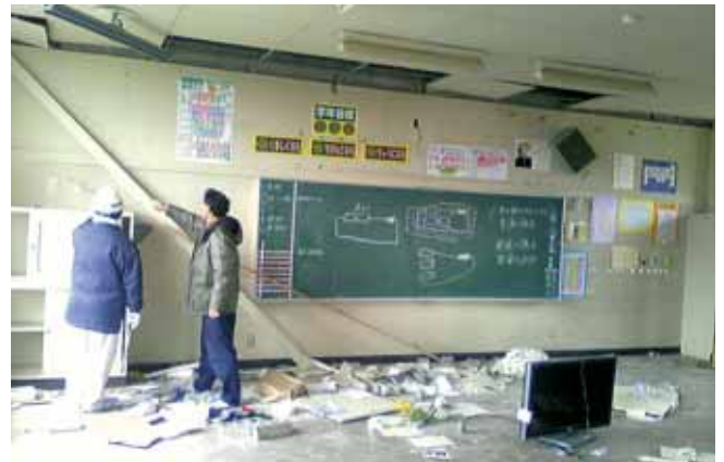
落下した天井パネル（船迫小学校）
