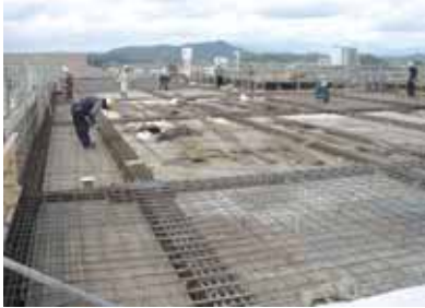
槻木中学校校舎改築工事
