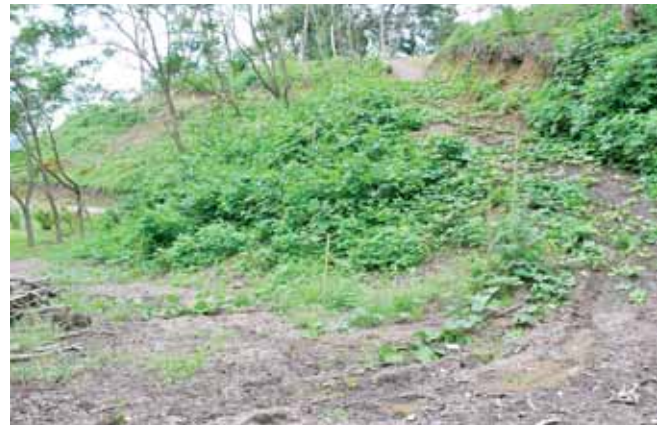
大量の土砂が流出した西船迫6号公園
