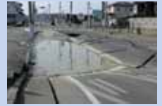
液状化による陥没 (大沼通線)
