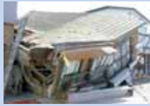
倒壊した家屋 (槻木)
