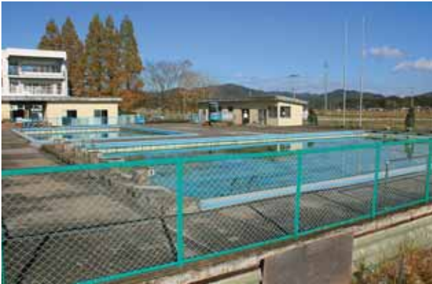
槻木小学校プール（解体前）
